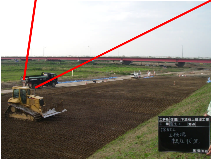
15t級ブルドーザー転圧状況
