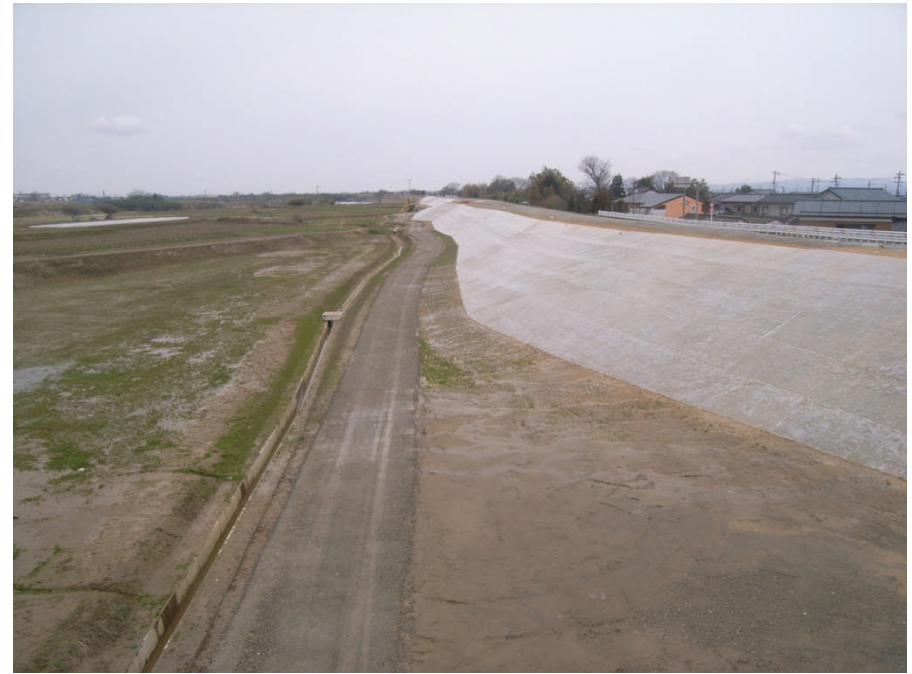
盛土完了全景
