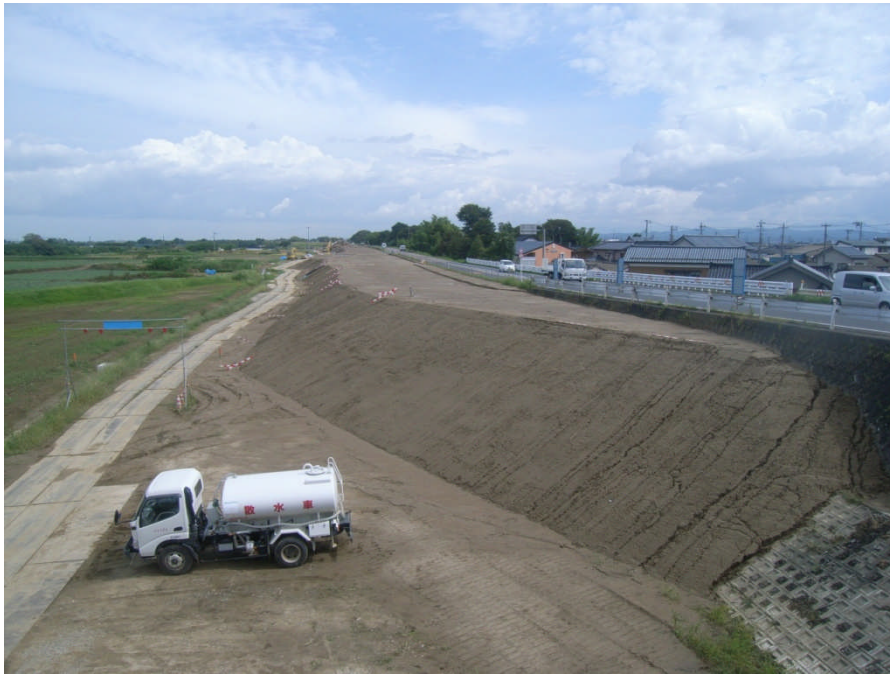
採取土を使用した盛土 完了全景
